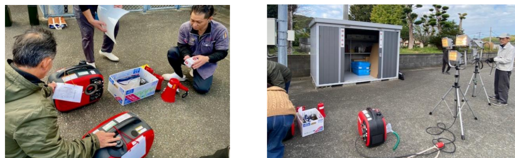
防災倉庫の点検作業
