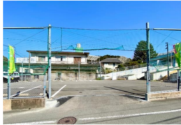
駐車場の出入口を拡張いたしました
